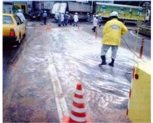
ロードクリーンエコによる流出油処理作業風景
